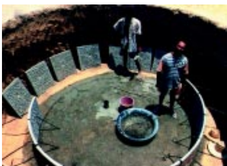
6 - Assentamento das placas laterais.
