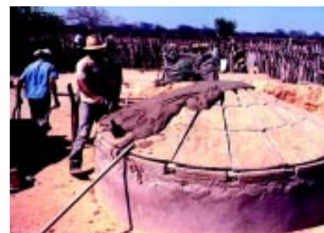
11 - Fechamento da cisterna.
