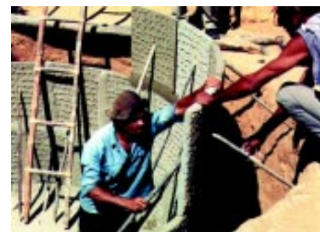
8 - Assentamento das placas superiores.
