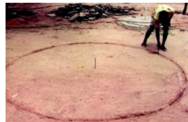
1 - Marcação do terreno.
