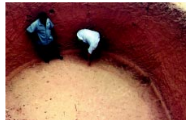
2 - Escavação do solo.
