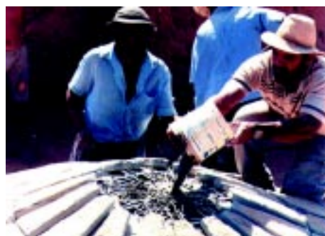
10 - Concretagem da amarração.
