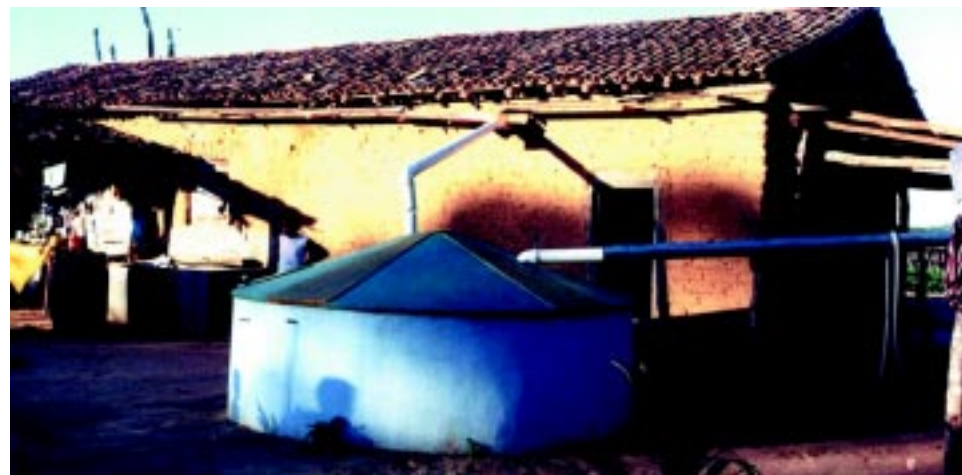
Cisterna pronta tem água suficiente para abastecer uma família por nove meses
