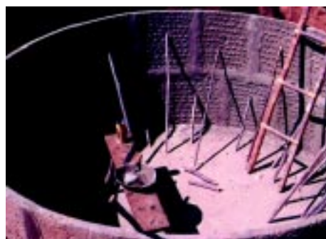
7 - Cisterna começa a ganhar forma.
