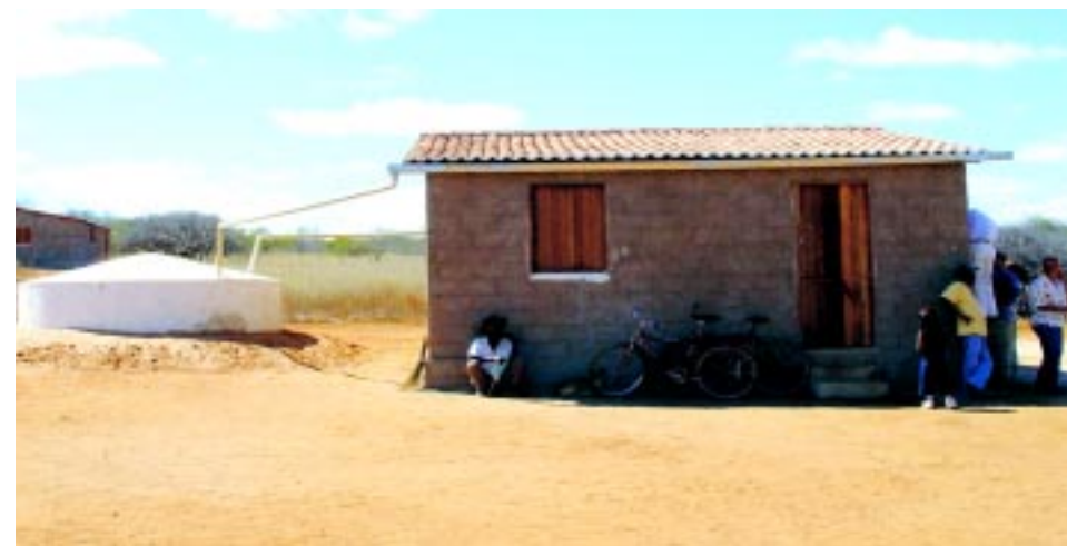
Casas de alvenaria foram necessárias para suportar o telhado de 40 metros quadrados
