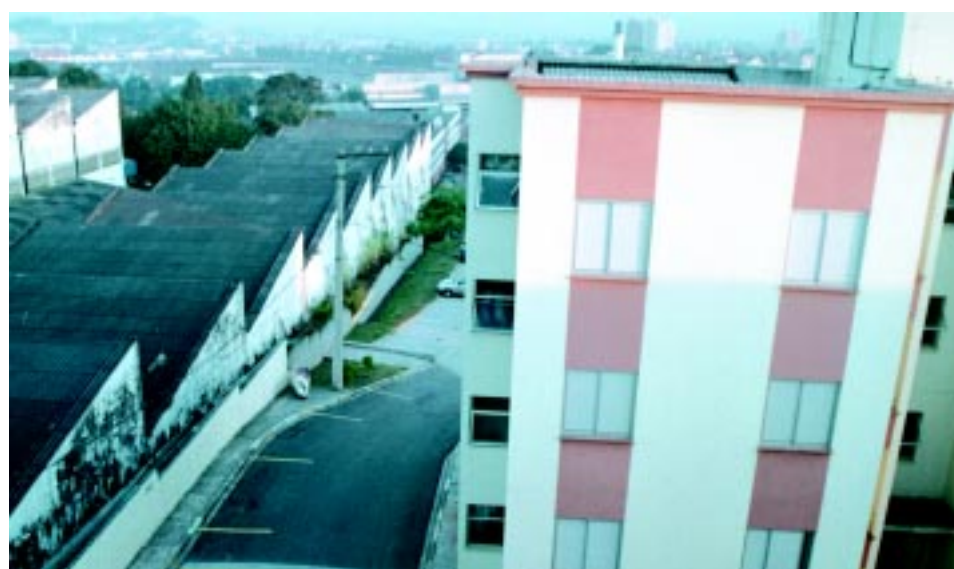
Um dos blocos do conjunto San Genaro, construído irregularmente em área industrial
