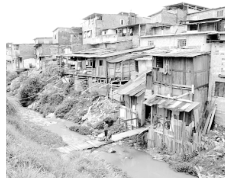
Córrego Taioca, no Jardim Cristiane, receberá ponte e piscinão
