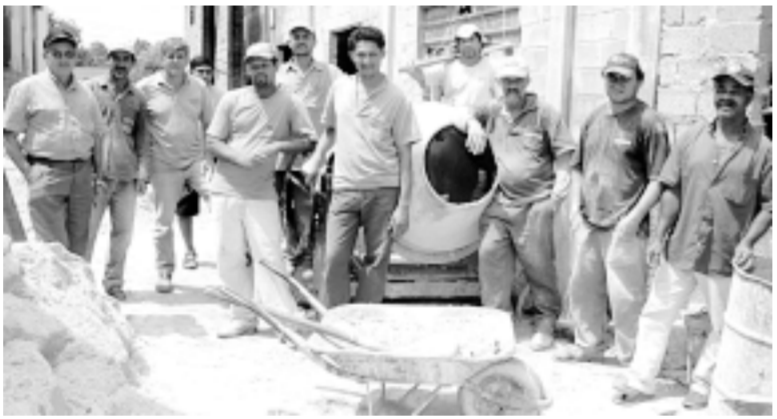
Companheiros da Coopprofis em obra de creche no Jardim Las Palmas
