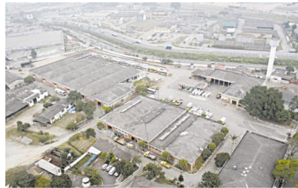
Obras foram iniciadas na área que vai sediar o campus da UFABC na Av do estado em Santo André
