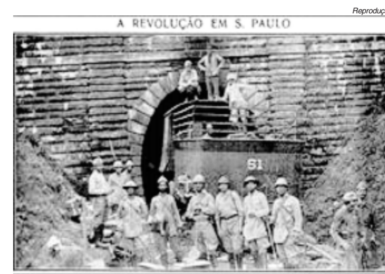
Soldados paulistas em posição no túnel da Mantiqueira ao Leste do Estado
