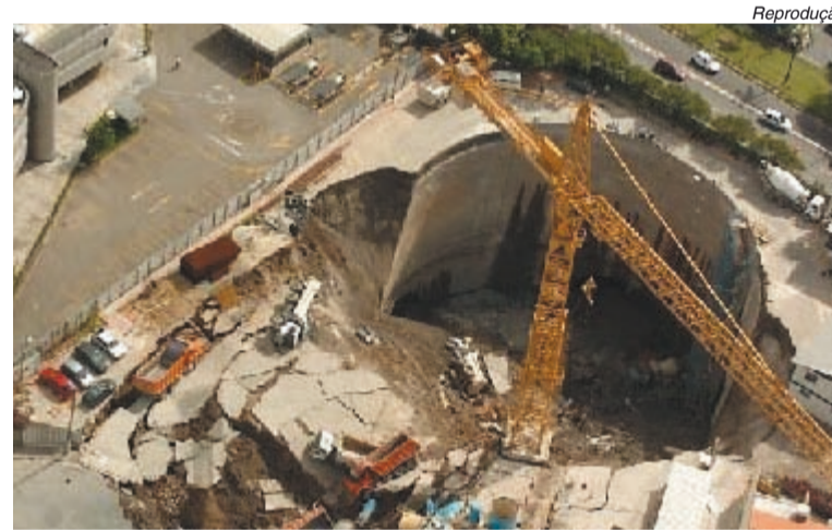
Cratera gerada pelo desmoronamento na futura estação Pinheiros
