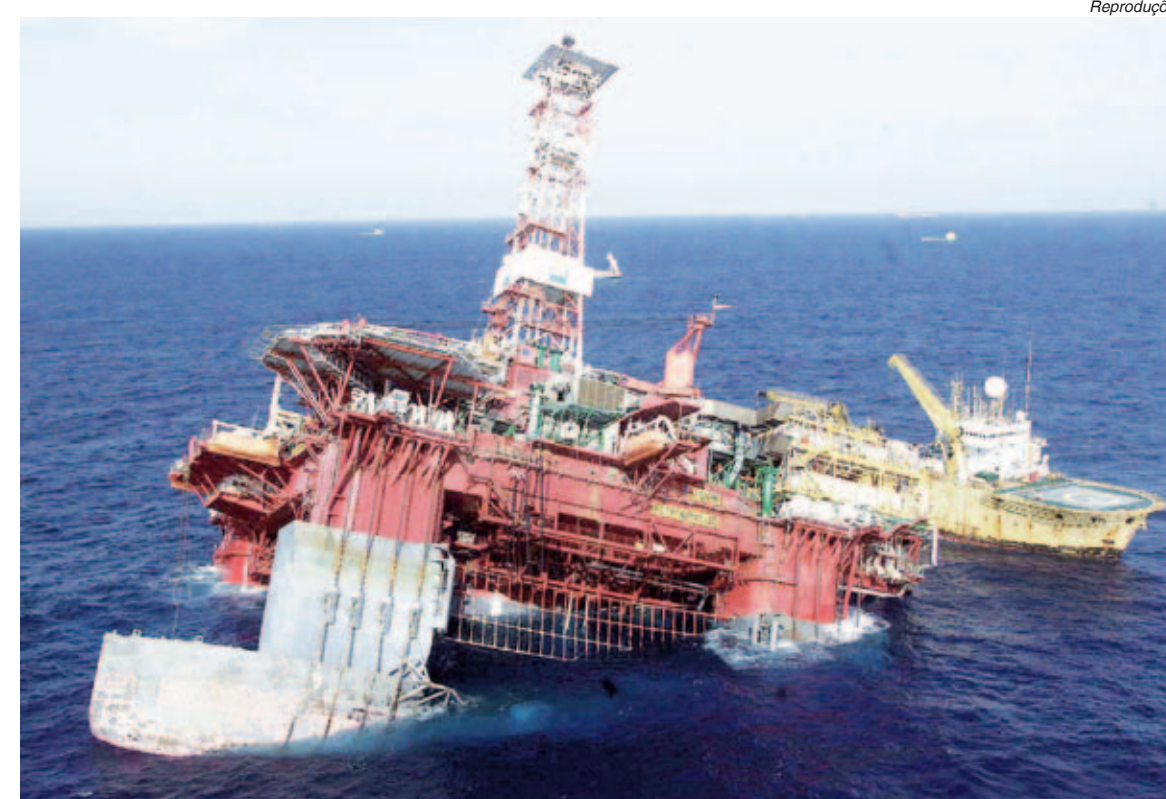
Falta de investimentos na Petrobras proporcionou o afundamento da plataforma P 36
